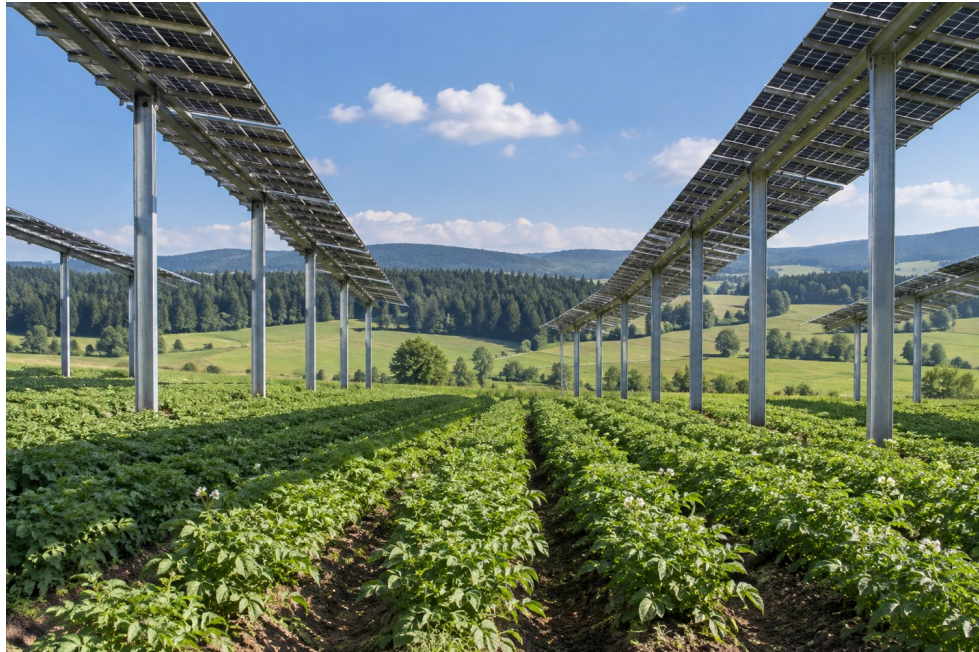
Abbildung 5: Agri-Photovoltaik-Anlage über einem Kartoffelfeld.
